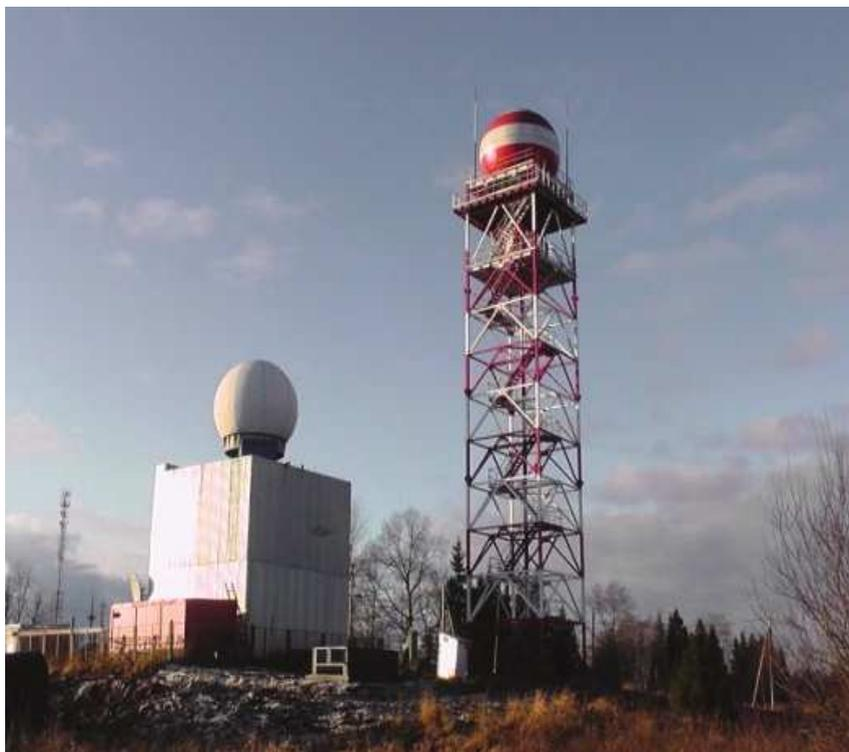
Рис. 54. Поляризационный доплеровский метеорологический радиолокатор С-диапазона, установленный на Валдае
